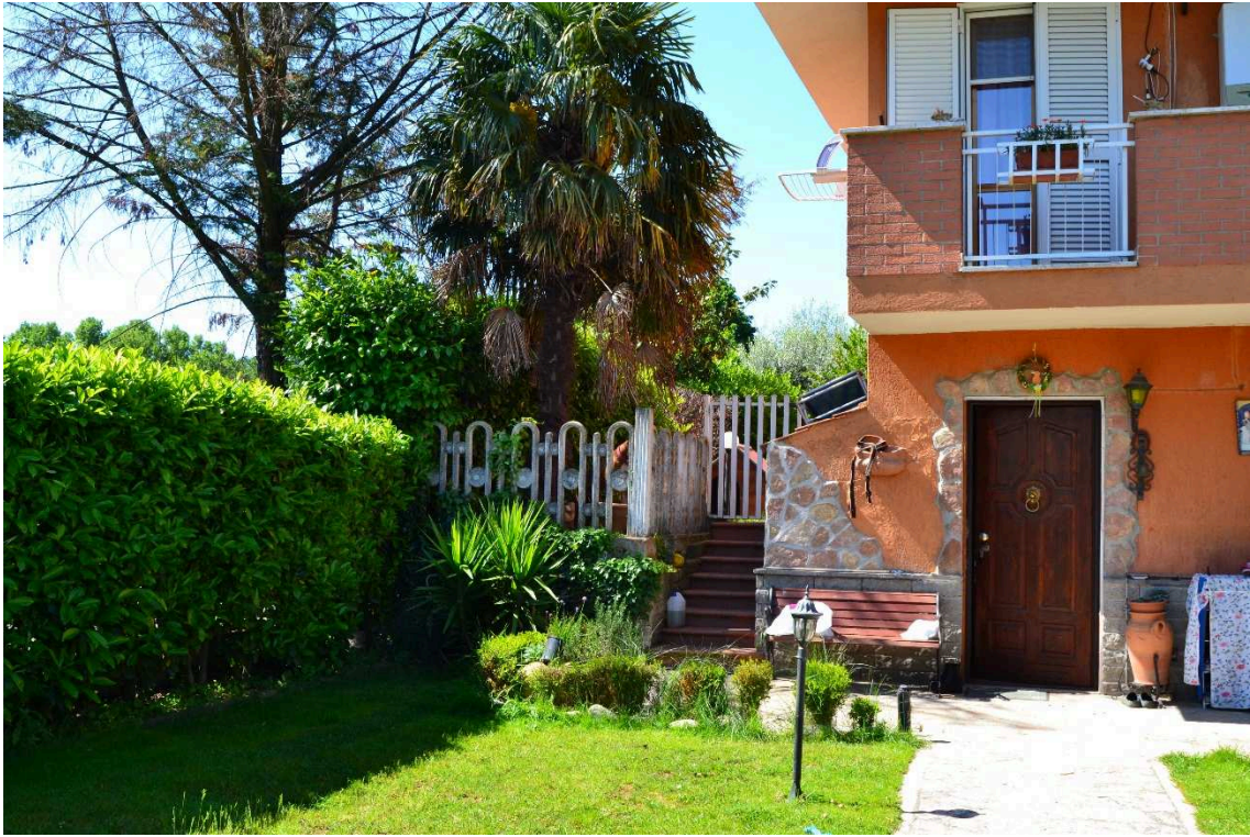
Foto 04 – Ingresso abitazione e porzione giardino da riportare in quota
