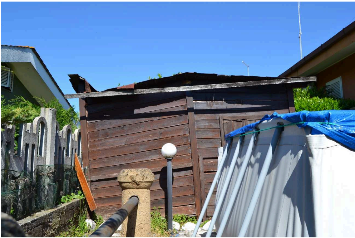
Foto 06 – Casetta in legno da demolire
